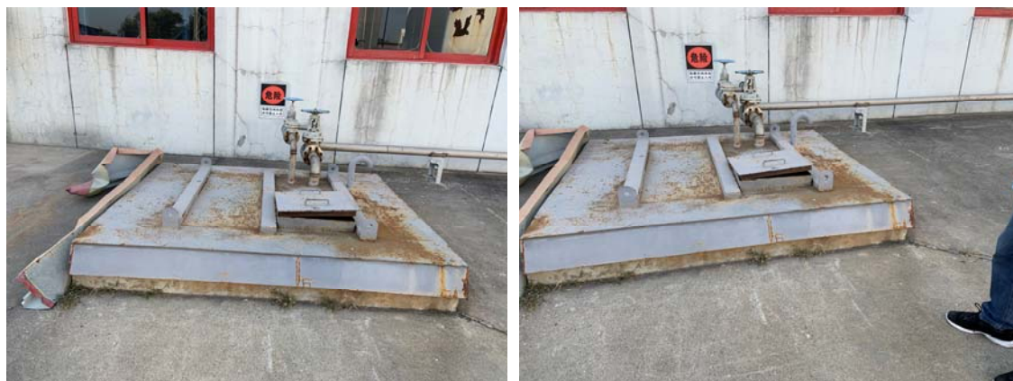
图 4.1-5 事故池检查照片
